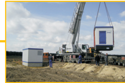
Anlieferung der Wechselrichterstationen
