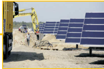
Ausheben des Kabelkanals
