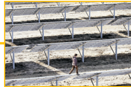
Unterkonstruktion eines Modultisches
